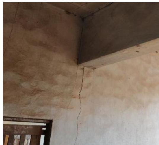
Photo 2 –Influence d'un panneau en maçonnerie sur un autre(a) ; mur porteur surchargé à l'Institut Chrétien Congolais de Bolenge dans la ville de Mbandaka (b)
