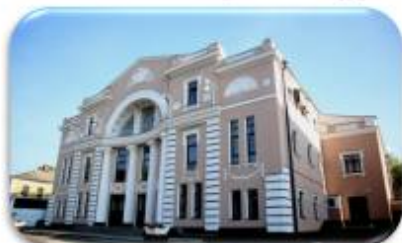
Реставрация здания Мичуринского драматического театра г. Мичуринск
