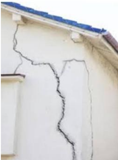
Photo 2 –Influence d'un panneau en maçonnerie sur un autre(a) ; mur porteur surchargé à l'Institut Chrétien Congolais de Bolenge dans la ville de Mbandaka (b)
