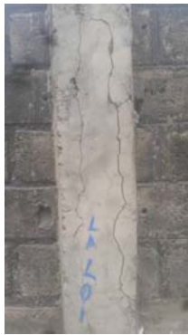
Photo1 –Cas de surcharge d'une colonne du rez-de-chaussée d'un bâtiment R+2 dans la commune de Kasa-Vubuà Kinshasa(a) ; tassement sous un mur de clôture dans la commune de Mateteà Kinshasa(b)
