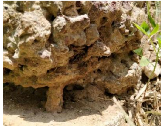
Photo 5–Cas d’enrobage insuffisant dans le lit supérieur d’armatures de la dalle de l’étage 2 d’un bâtiment R+4 dans la commune de Lingwala à Kinshasa (a) ; armature d’une colonne complètement à découvert à l’Institut Moteyi de Mbandaka
