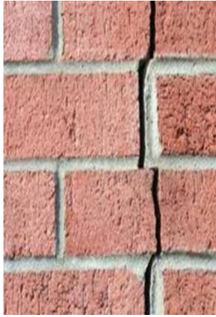
Photo 3 –Mur avec des joints verticaux mal réalisés (a) ; mur soumis à des régimes d’humidité et de température différents dans la commune de Barumbu à Kinshasa
