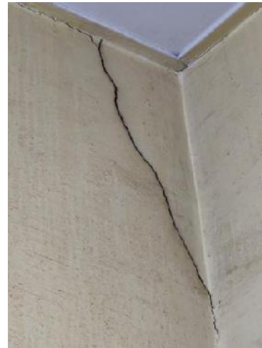
Photo 3 –Mur avec des joints verticaux mal réalisés (a) ; mur soumis à des régimes d’humidité et de température différents dans la commune de Barumbu à Kinshasa
