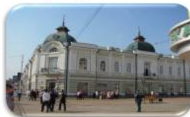
Реставрация здания «Музейно-Выставочный центр» г. Тамбов
