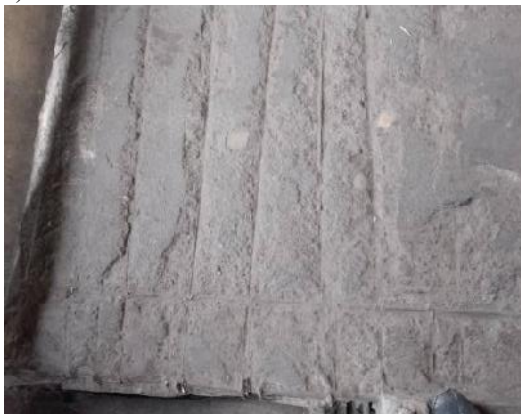
Photo 5–Cas d’enrobage insuffisant dans le lit supérieur d’armatures de la dalle de l’étage 2 d’un bâtiment R+4 dans la commune de Lingwala à Kinshasa (a) ; armature d’une colonne complètement à découvert à l’Institut Moteyi de Mbandaka
