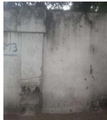
Photo1 –Cas de surcharge d'une colonne du rez-de-chaussée d'un bâtiment R+2 dans la commune de Kasa-Vubuà Kinshasa(a) ; tassement sous un mur de clôture dans la commune de Mateteà Kinshasa(b)
