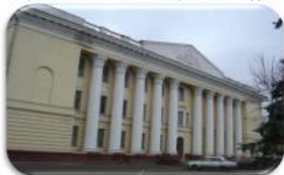
Реставрация здания «Тамбовский областной краеведческий музей» г. Тамбов
