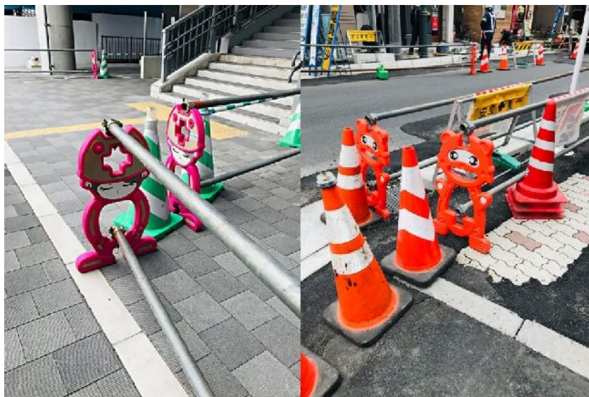
Рисунок 5 – Строительные ограждения, г. Токио (фото Крохалев В. С.)
