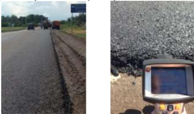
Рисунок 4 - Съемка тепловизором края укладываемой полосы
