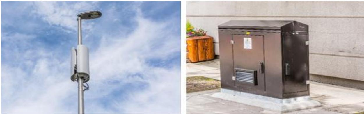
**Рис. 5.6. Пример антенной системы, поддерживающей малые соты, и уличный шкаф**
