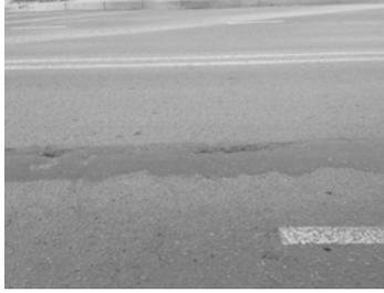
**Рис. 4.2. Разрушение дорожного покрытия на стыке смежных полос**
