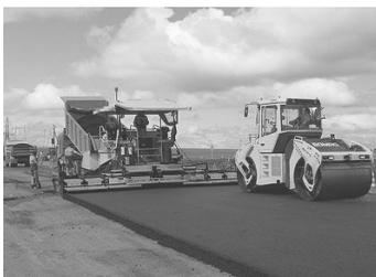
**Рис. 3.1. Технологический процесс строительства покрытия нежесткого типа одним асфальтоукладчиком**
