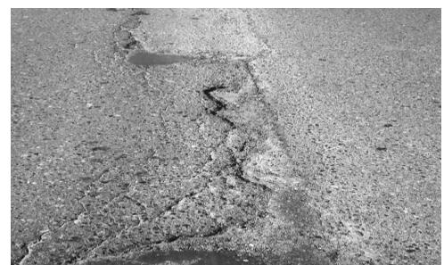
**Рис. 2.6. Динамика развития разрушения дорожного покрытия в зоне стыка полос**
