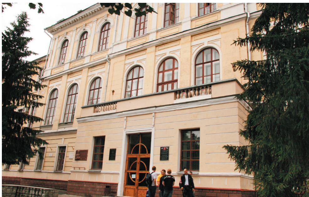
Учебно-лабораторный корпус ТГТУ на ул. Ленинградской, 1
