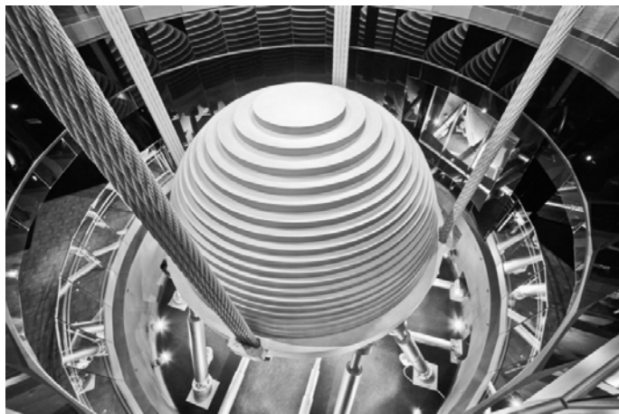
Рис. 4.8. Инерционный демпфер небоскреба Тайбей 101
