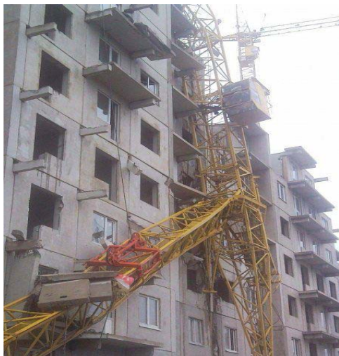
Рис. 3.52. Падение двух башенных кранов, Санкт-Петербург
