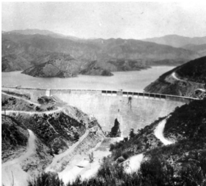
Рис. 3.31. Трещина в плотине Сен-Френсис
