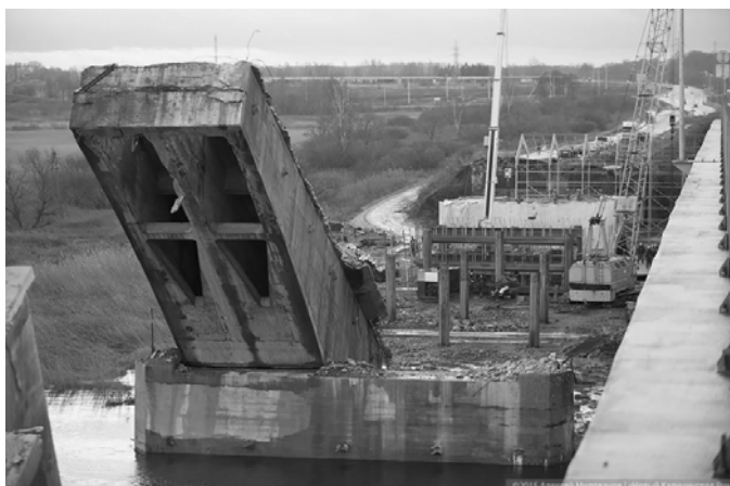
Рис. 3.24. Обрушение Берлинского моста
