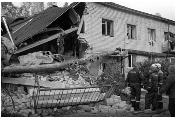
Рис. 3.7. Обрушение подъезда жилого дома, г. Ярославль
