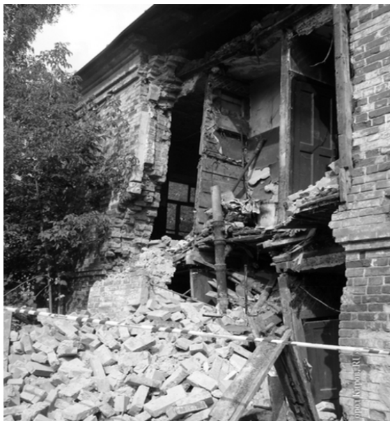
Рис. 3.9. Обрушение стены дома, г. Киров
