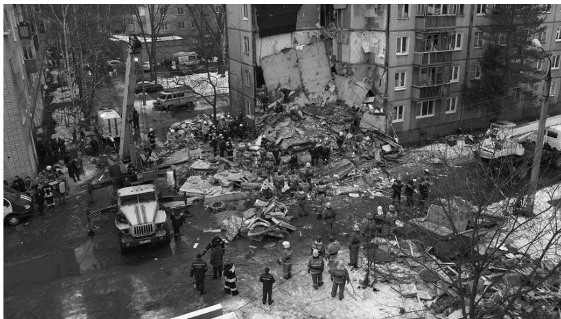
Рис. 3.49. Разрушение дома в результате взрыва газа, г. Ярославль
