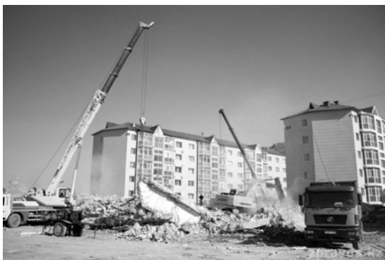
Рис. 3.6. Обрушение новостройки, г. Караганда
