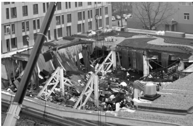
Рис. 3.20. обрушение торгового центра Maxima
