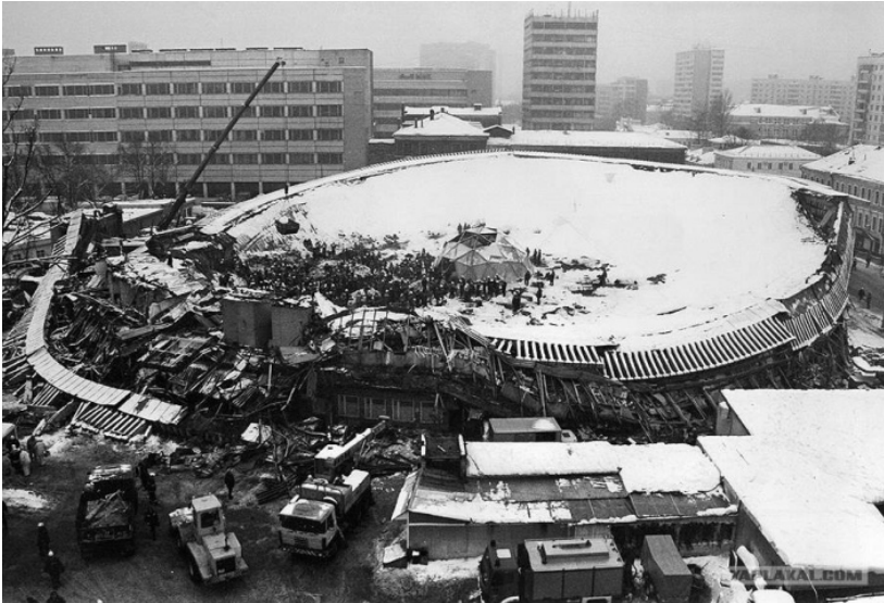
Рис. 3.15. Обрушение кровли Басманного рынка
