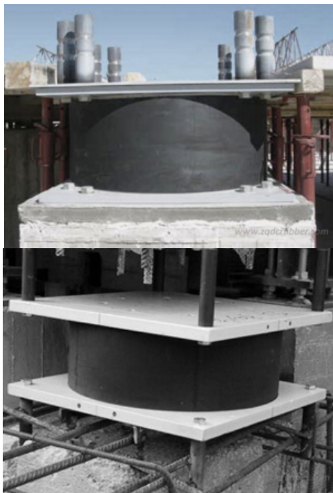
Рис. 4.12. Свинцово-резиновая опора
