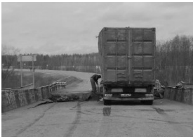
Рис. 3.26. Частичное обрушение (проседание дорожного полотна) автомобильного моста
