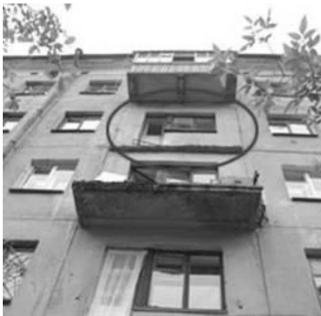
Рис. 3.10. Обрушение балкона жилого дома, г. Пермь
