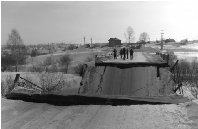
Рис. 3.25. обрушение двух пролетов железобетонного моста через р. Шурап
