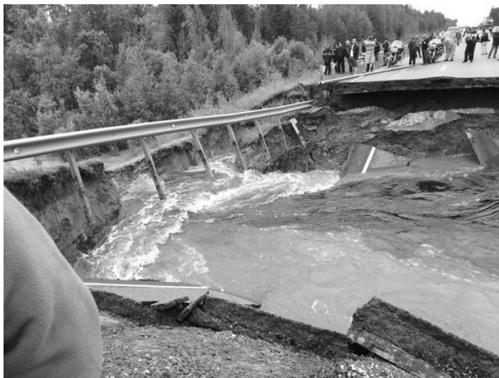
Рис. 4.16. Размытие грунта автодороги Тюмень – Ханты-Мансийск
