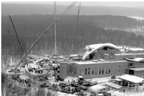
Рис. 3.14. Обрушение Трансвааль-парка, г. Москва
