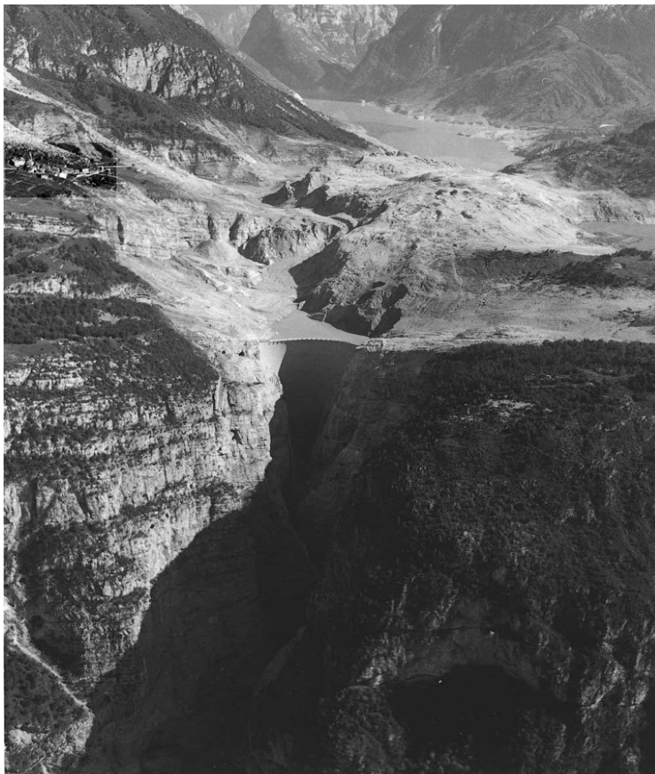
Рис. 3.33. Вид плотины после оползня
