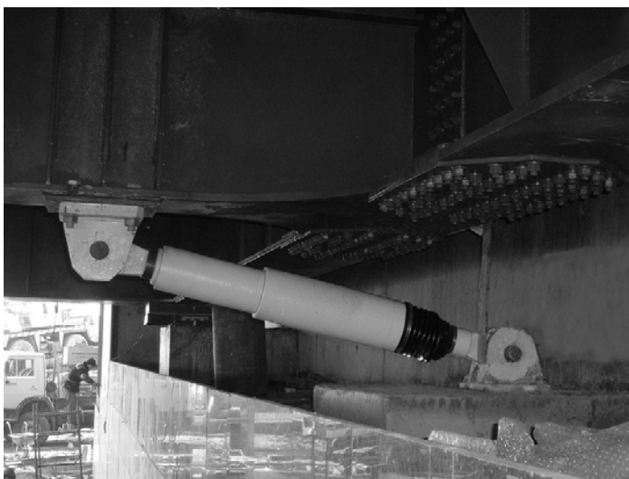
Рис. 4.9. Гистерезисный демпфер
