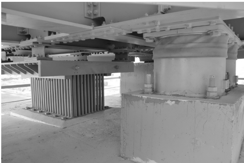
Рис. 4.7. Сейсмозащита моста в Казахстане
