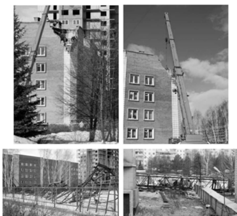
Рис. 3.51. Падение строительного крана на жилой дом, г. Якутск
