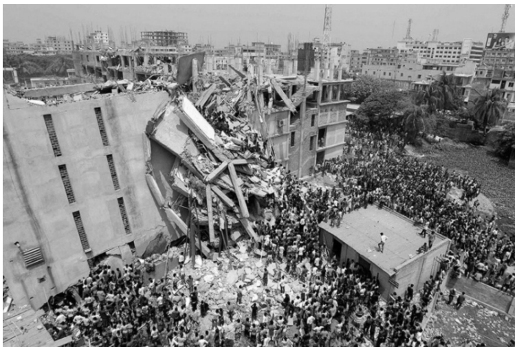
Рис. 3.16. Обрушение 8-этажного здания, Бангладеш
