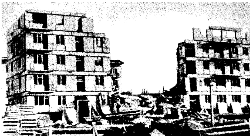
Рис. 3.1. Обрушение стены 5-этажного дома, г. Куйбышев
