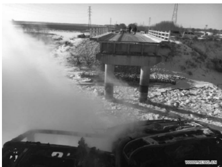
Рис. 3.27. Обрушение моста через р. Цицикар
