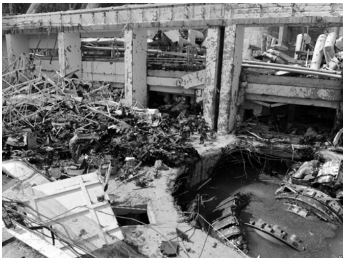
Рис. 3.36. Разрушения машинного зала Саяно-Шушенской ГЭС
