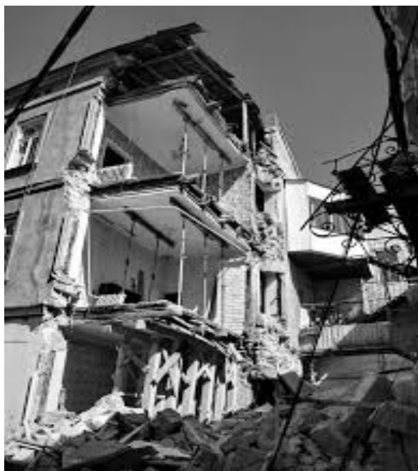
Рис. 3.5. Обрушение жилого дома, г. Одесса
