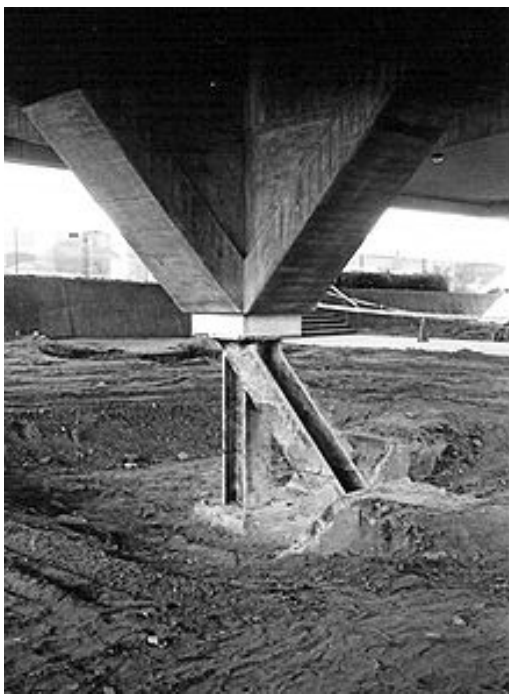
Рис. 4.11. Приподнятое основание здания
