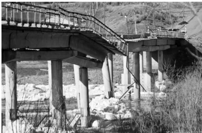
Рис. 3.23. Обрушение пролета железобетонного моста
