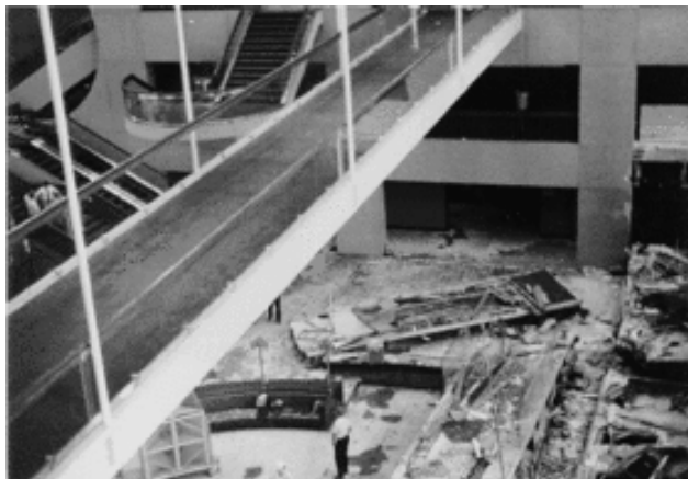
Рис. 3.18. Обрушение галерей гостиницы Hyatt Regency
