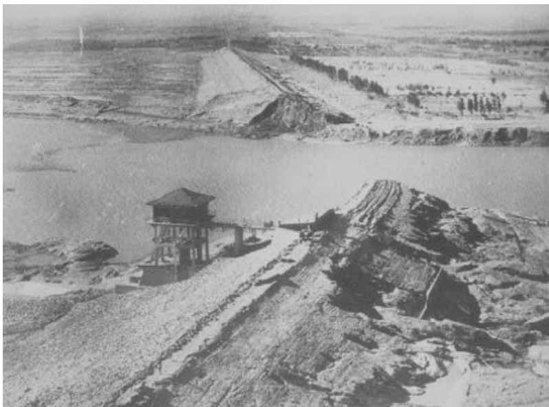
Рис. 3.29. Разрушение плотины Баньцяо, Китай
