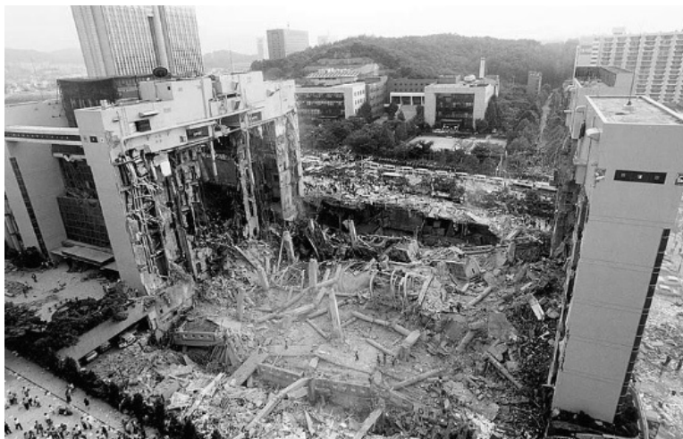
Рис. 3.13. Обрушение супермаркета Sampoong, Южная Корея
