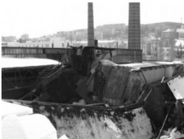
Рис. 3.19. Обрушение крыши 2-этажного производственного цеха, г. Саратов
