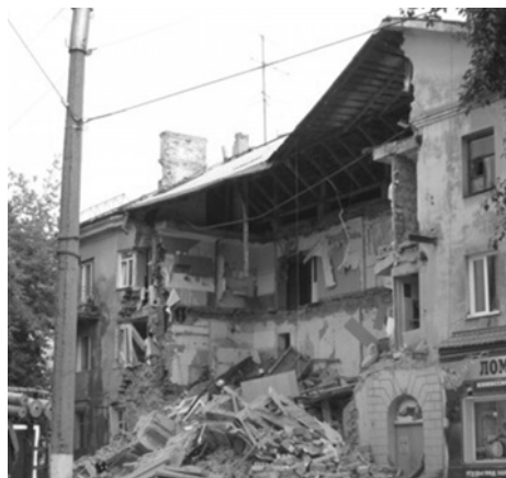
Рис. 3.8. Обрушение части жилого дома, г. Барнаул
