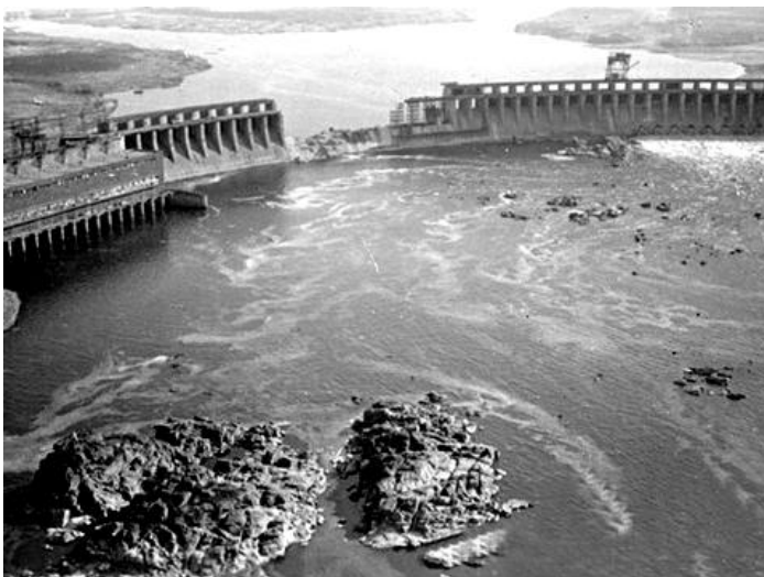
Рис. 3.34. Плотина Днепрогэс после взрыва
