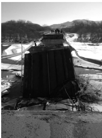
Рис. 3.28. Обрушение автомобильного моста через р. Литовка
